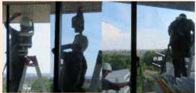
↑部屋の前のベランダに鳩が来るので、鳩除けネットが設置されました。8階での工事。すごいな、こんな高い所で怖くない？と聞いたら、最初は怖かったけど慣れました、と言っていました。でも、命綱をつけての工事です。当然ですが。私には無理、絶対無理。足腰が震えて何もできませんから。
